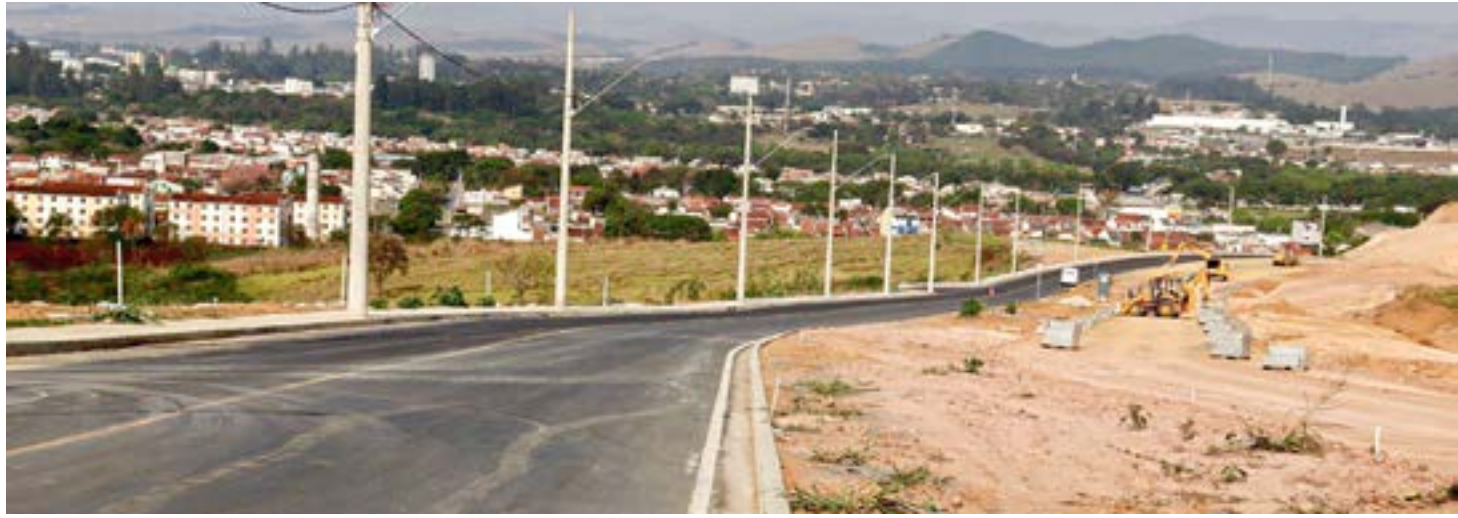
Entregue na última segunda-feira, a "Avenida S", que é a primeira etapa da alça de acesso ao Santuário Frei Galvão, em Guaratinguetá
