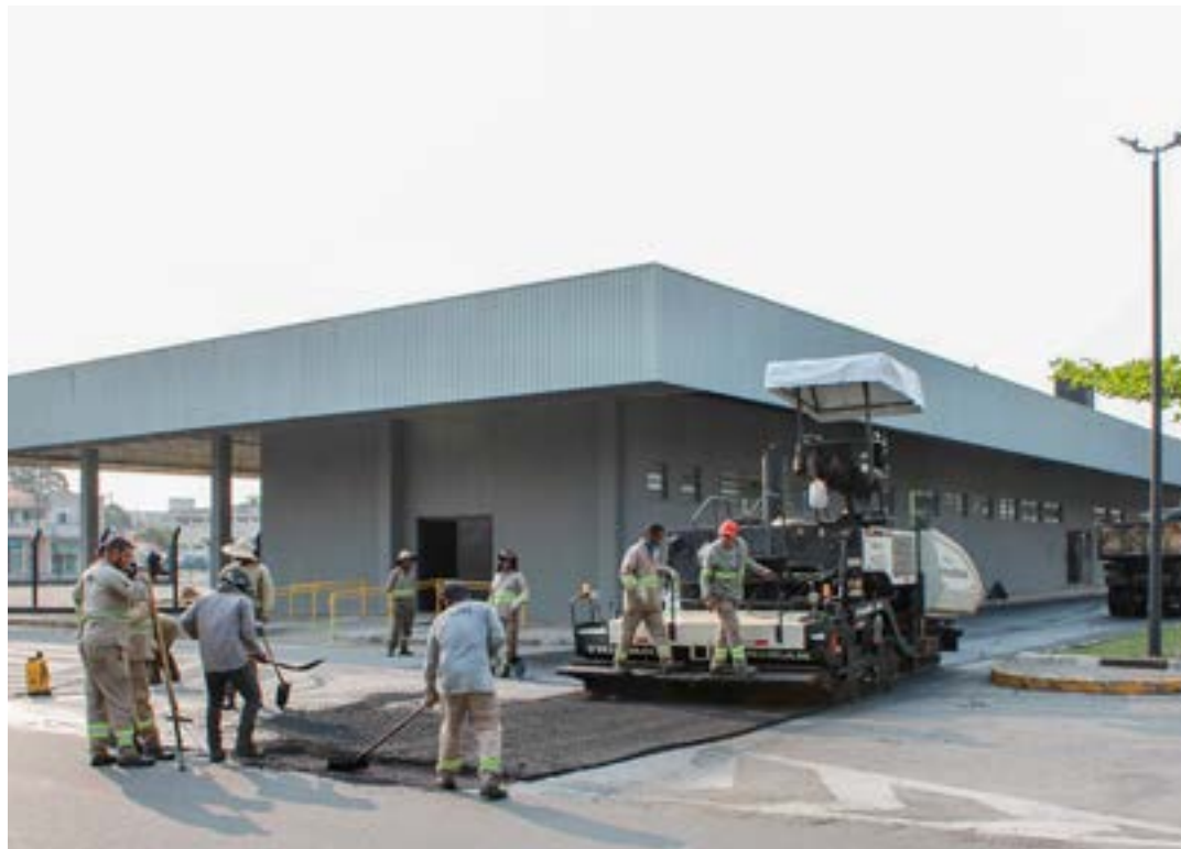
Obra de adequação da estrutura da antiga rodoviária para espaço para atender pessoas com deficiência
