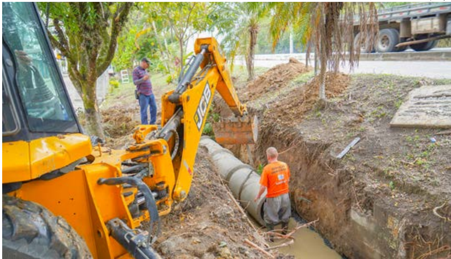
Trabalho de servidores em obra de drenagem no bairro do Olaria do Simão, em Lorena; ação conta com investimento de R$ 40 mil
