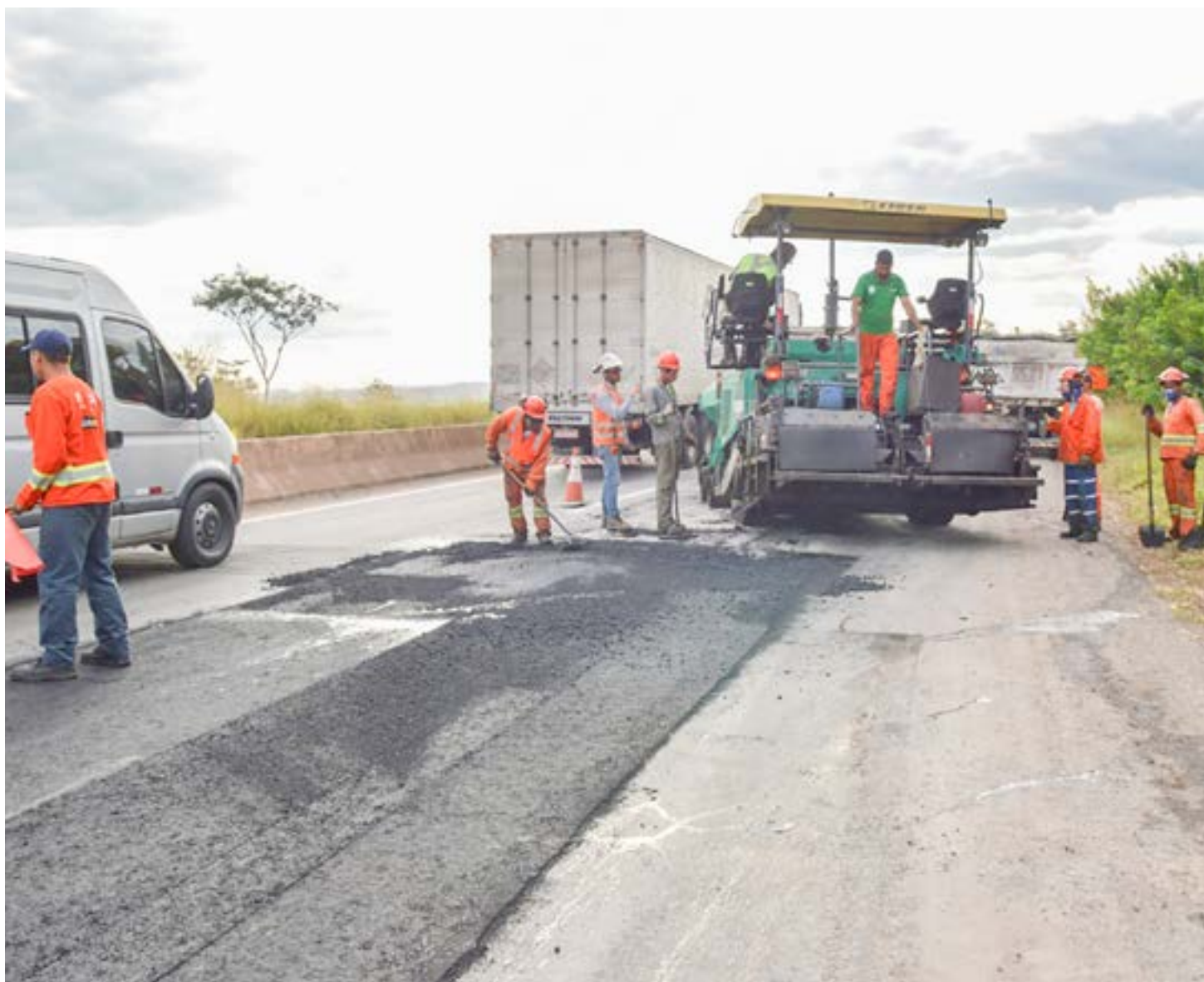
Trabalho para reestruturação de estrada; Prefeitura de Lorena adere a grupo de trabalhos que amplia atenção sobre licenças ambientais
