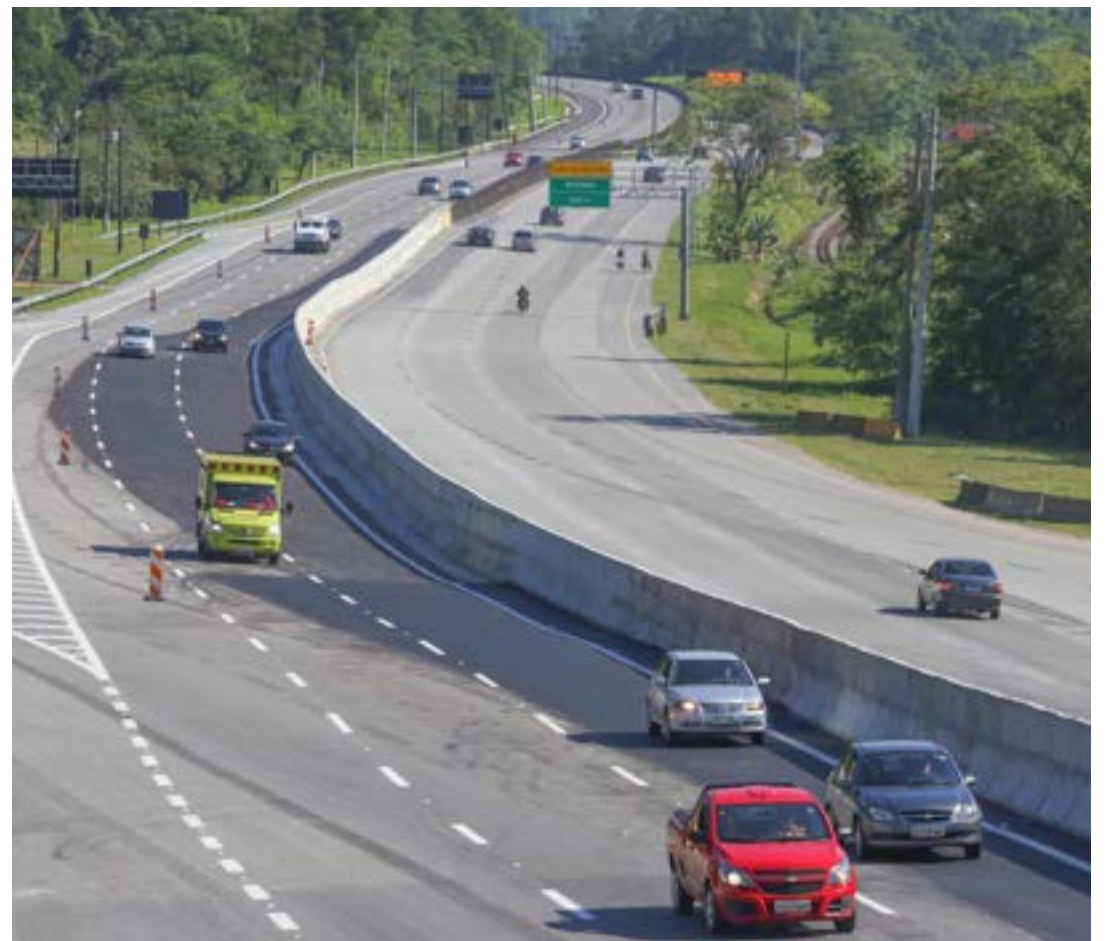
Movimentação na rodovia estadual Doutor Manuel Hypólito Rego, a SP-55, que recebe obras de adequação
