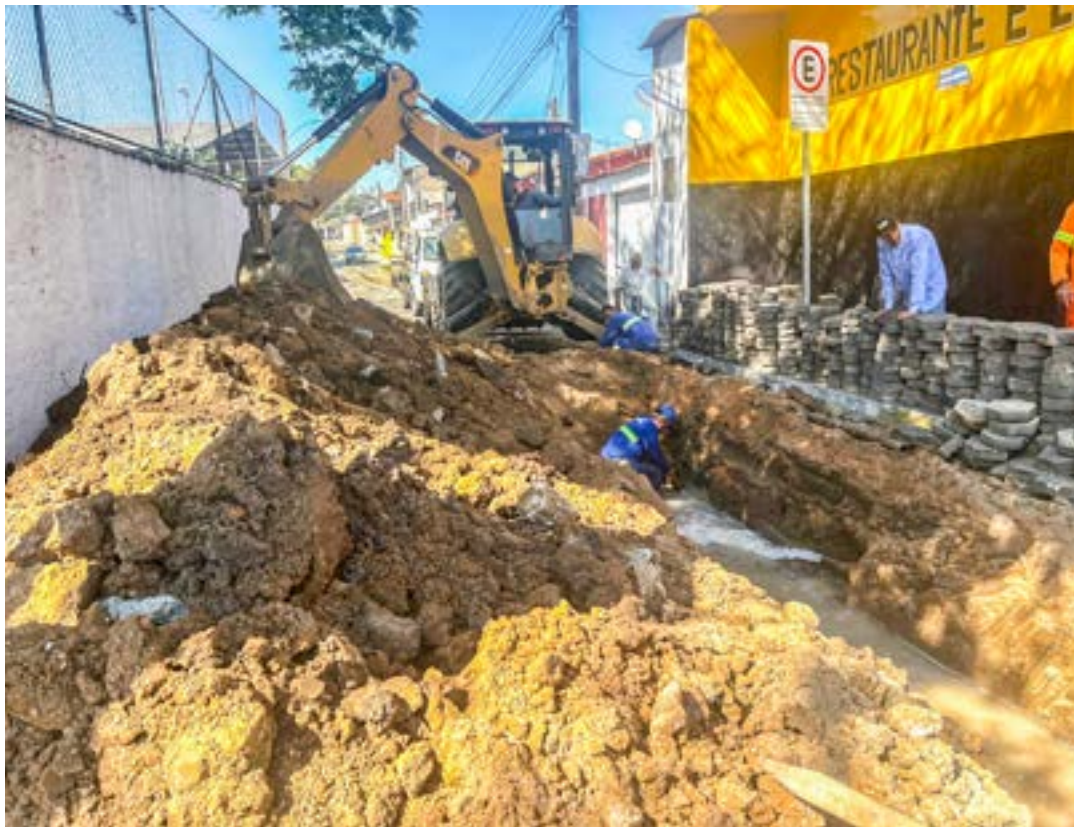
Obra de adequação do sistema de drenagem na rua Marcílio Marton; ação mantém plano de prevenção
