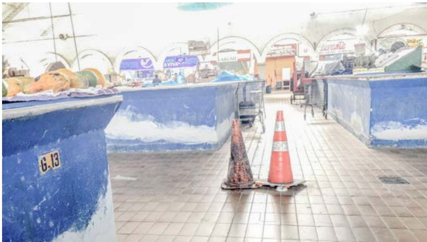
Área interna do Mercado Municipal de Guará; condições precárias fazem parte do dia a dia de quem trabalha no local, que segue sem obras
