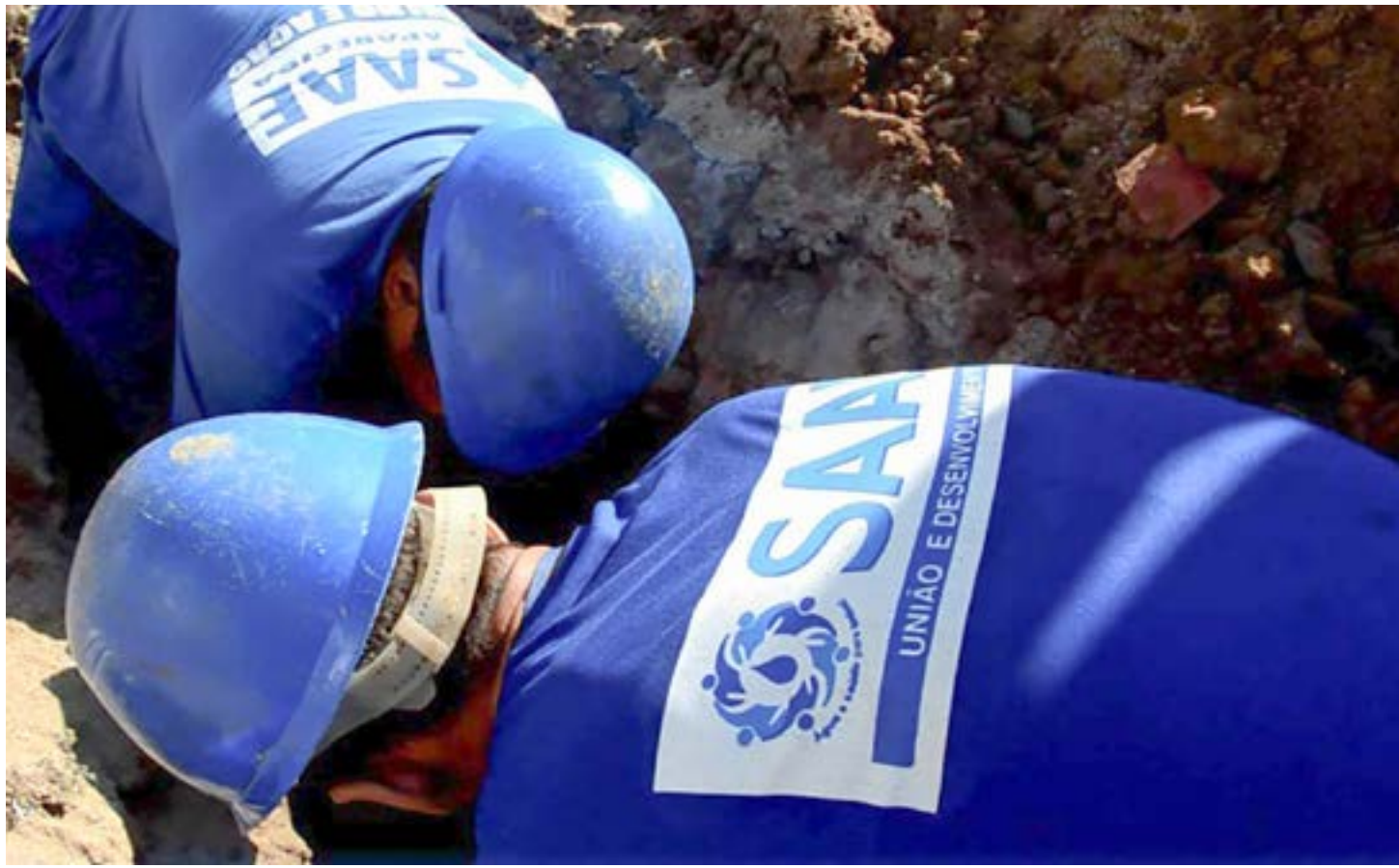
Trabalho realizado pela equipe do Saae em obra do saneamento básico; autarquia tem concurso aberto para contratação em Aparecida
