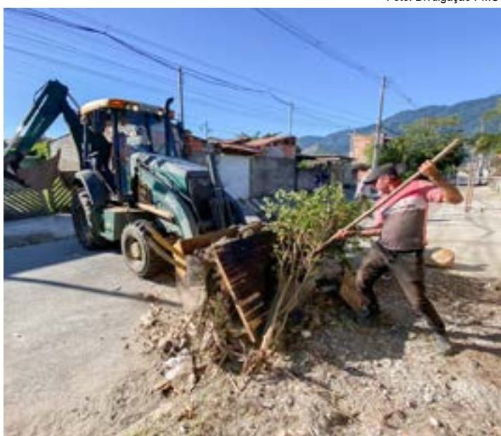
Trabalho de remoção de materiais descartados realizado Prefeitura
