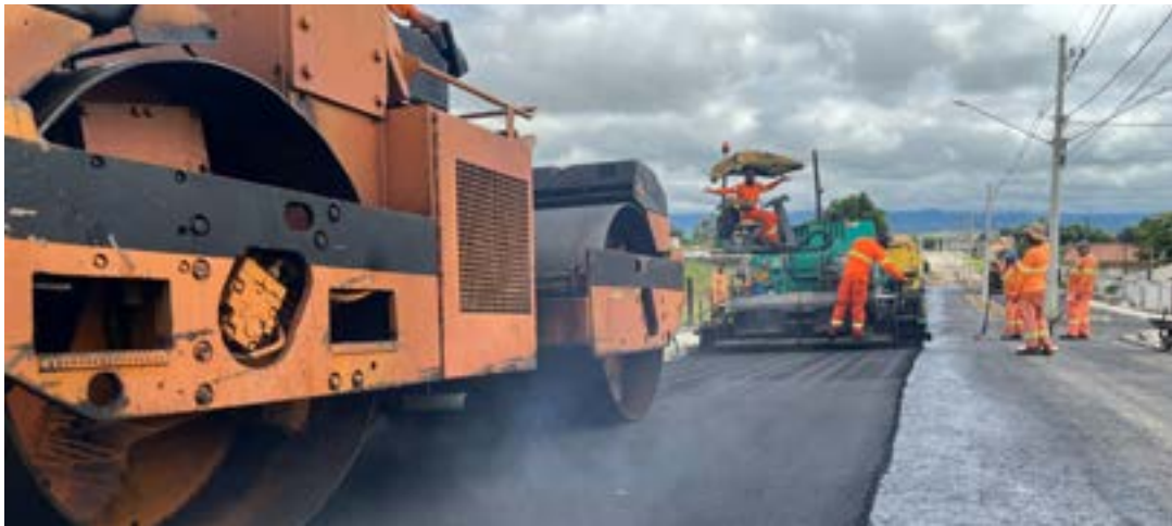
A pavimentação asfáltica na avenida Brasil; obra faz parte de plano para garantir mais segurança no trânsito
