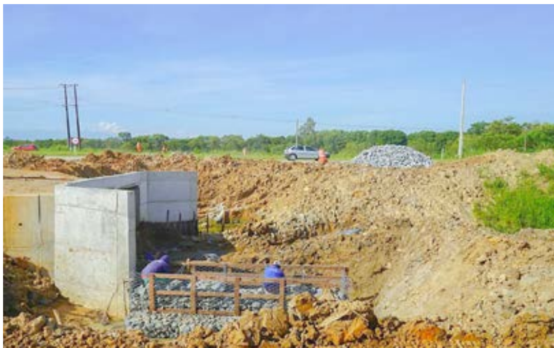
Obra de implantação de aduelas ao lado do Mandi; serviço visa prevenir enchentes e alagamentos no local
