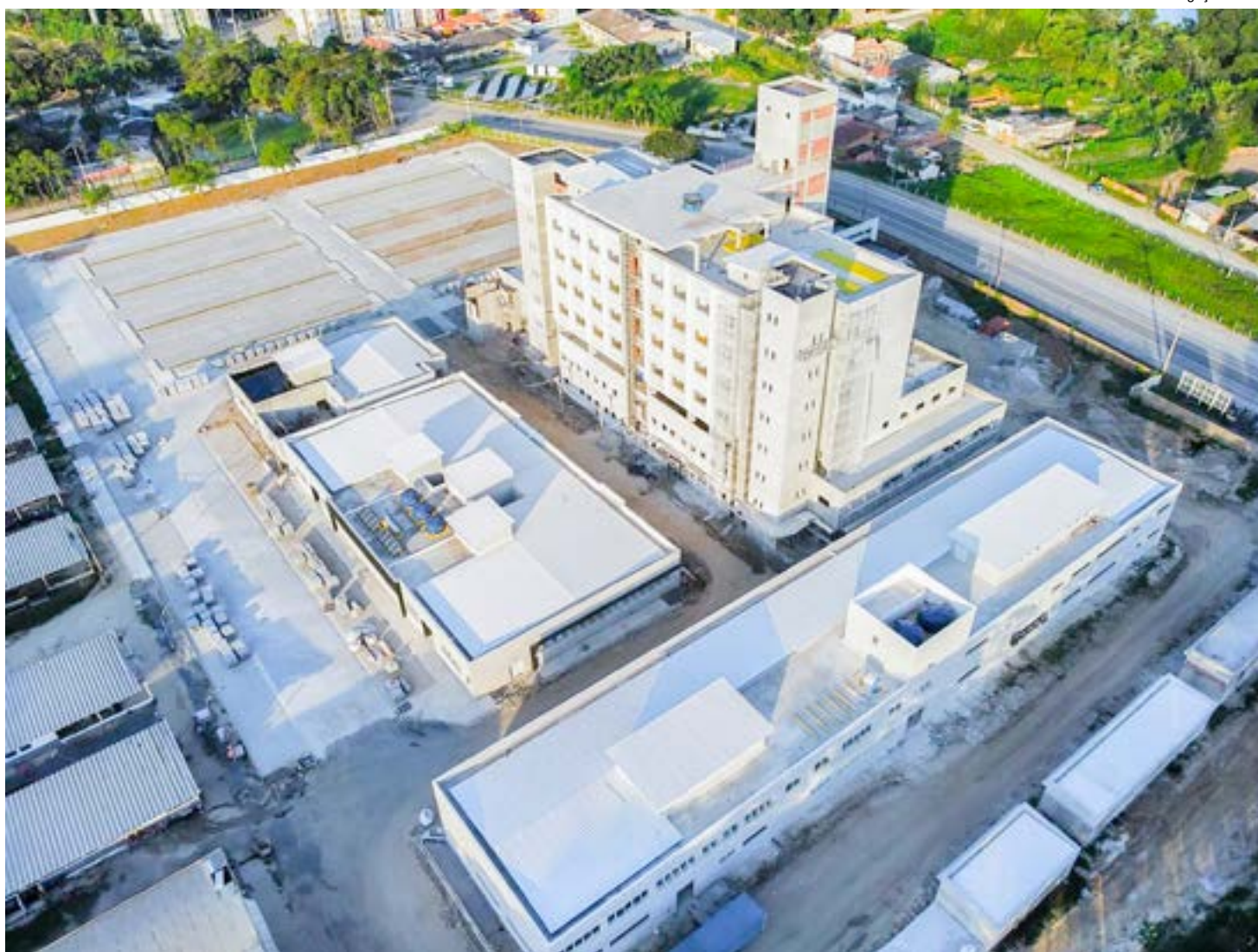
Vista aérea da construção do Hospital Regional de Cruzeiro; estrutura tem prognóstico de iniciar atendimento a partir do próximo ano
