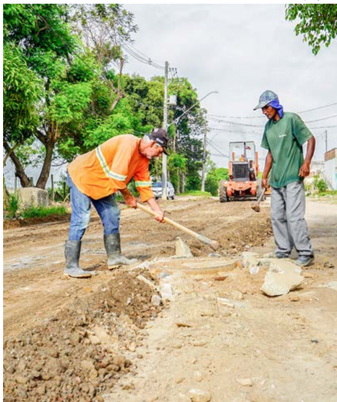
Trabalho de pavimentação nas ruas do bairro; investimento anunciado por Sylvio Ballerini é de R$ 1,9 milhão
