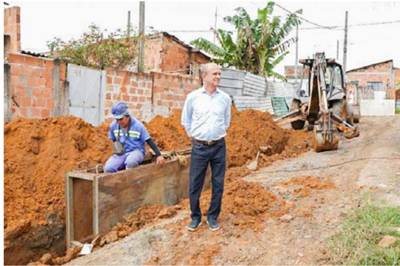
O prefeito de Lorena, Sylvio Ballerini, vistoria obra de saneamento em 2023; Lorena inicia atividades de novo plano estrutural
