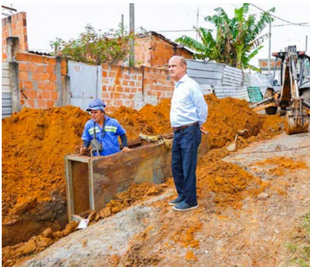
O prefeito de Lorena, Sylvio Ballerini, durante visita a obra de saneamento em 2022; Lorena tem novo plano
