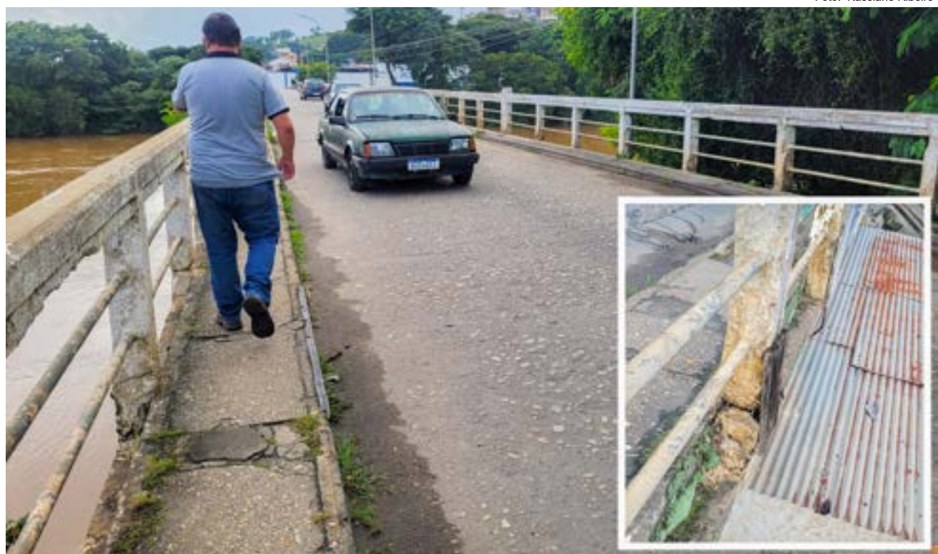
Com estrutura precária, base improvisada tem madeira amarrada em coluna de sustentação de parte da ponte Adhemar de Barros
