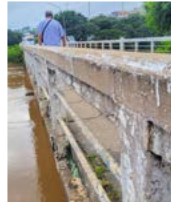
Ponte de acesso ao Itagaçaba
