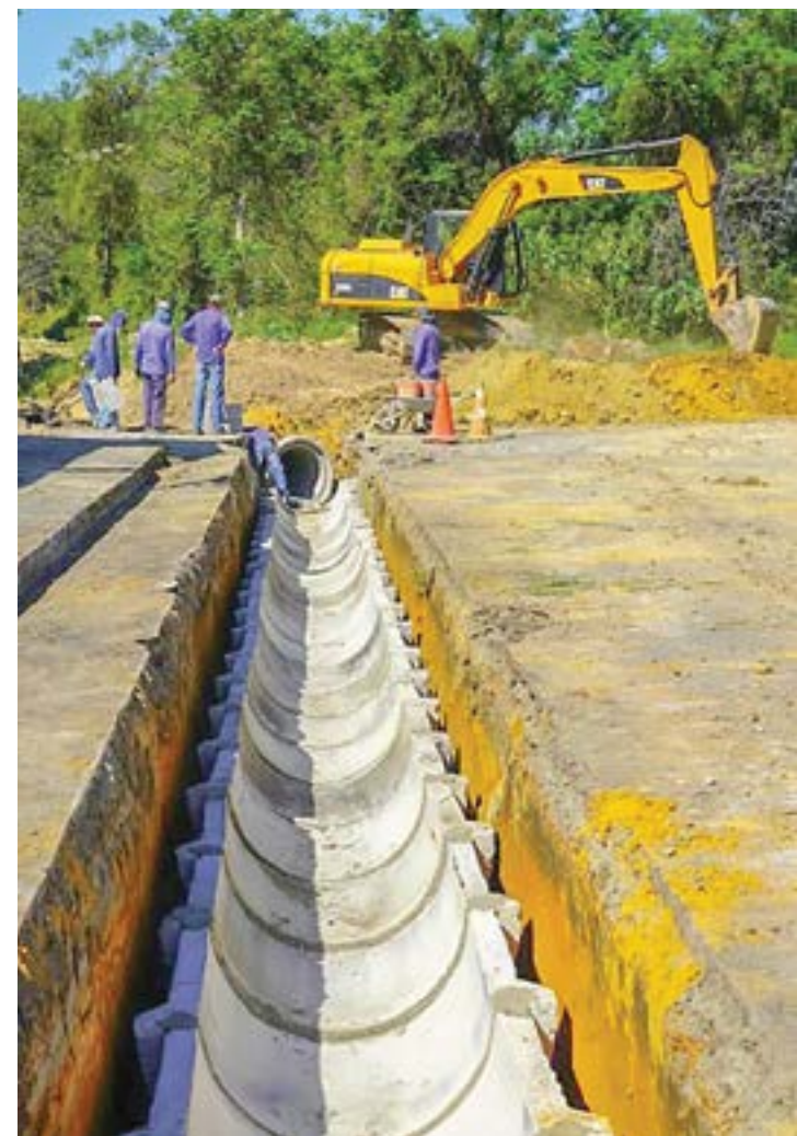
Obra na pavimentação da rua Joaquim Cardoso Machado, na Vila Geny
