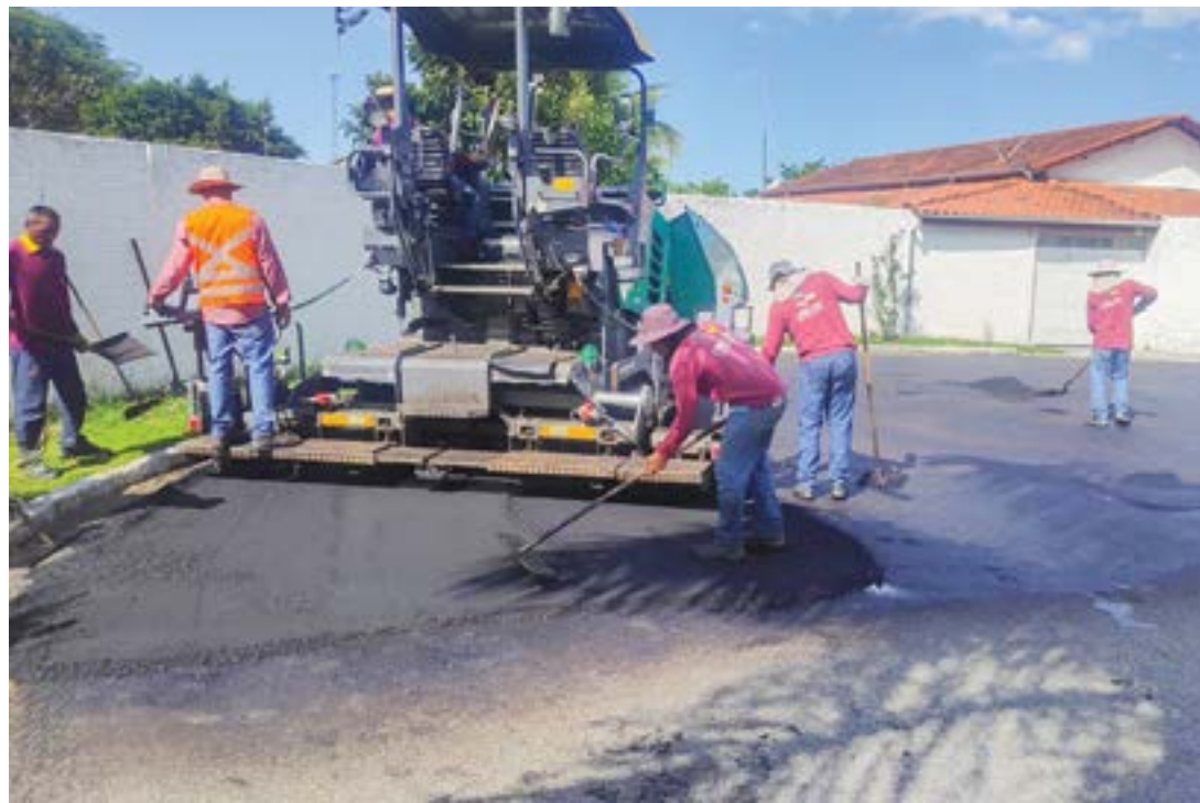
Trabalho da Prefeitura no recapeamento de via em Moreira César, investimento aproximado de R$ 53 milhões
