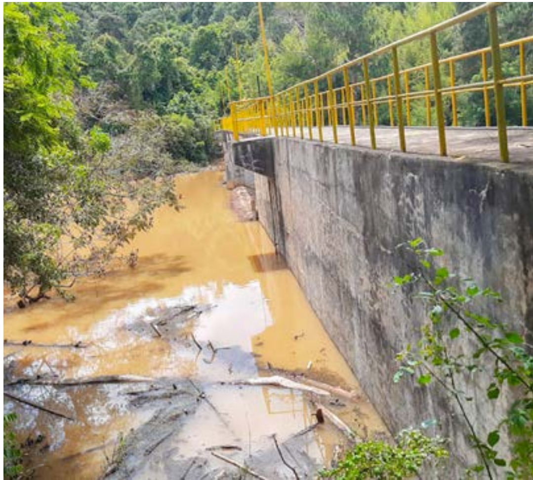
A barragem dos Mottas, em Aparecida, que está sob alerta para condições de risco para três municípios
