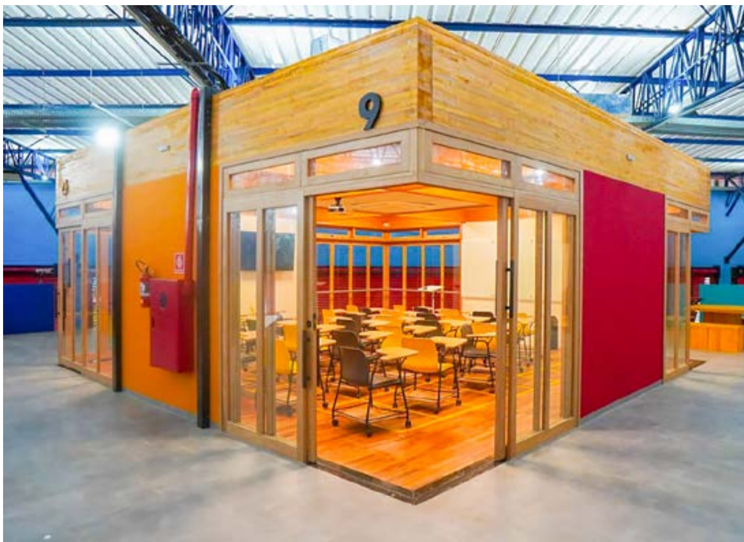
Sala de aula construída pelo Governo do Estado junto a outros espaços adaptados em escola da rede estadual; concluídas em oito meses
