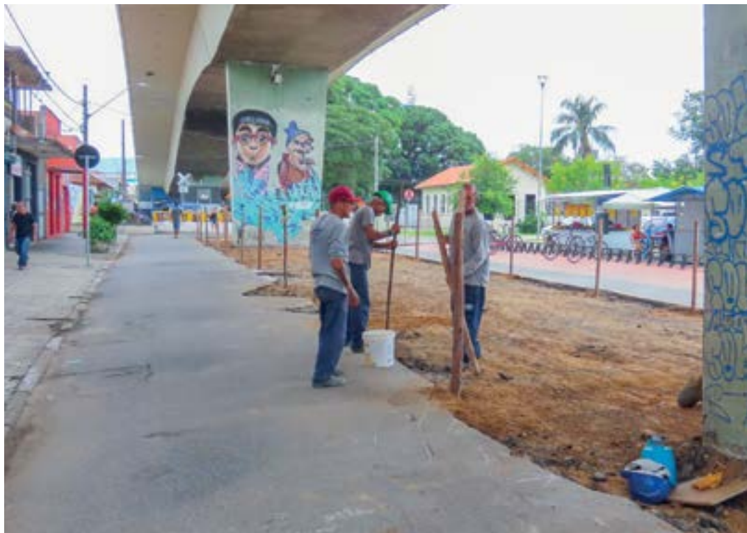
Trabalho de servidores realizado no viaduto João Kozlowsky, que fica na região central de Pindamonhangaba
