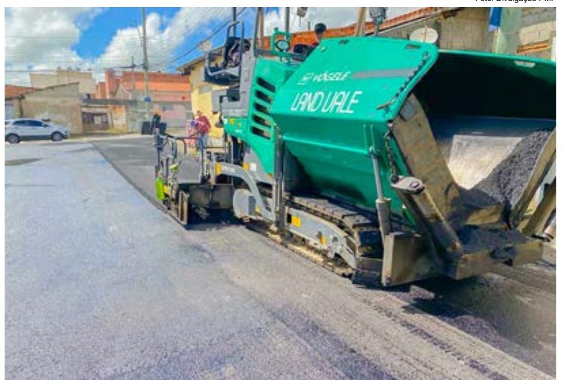
Trabalho com maquinário para recapeamento asfáltico; Pinda pretende revitalizar mais de setenta vias
