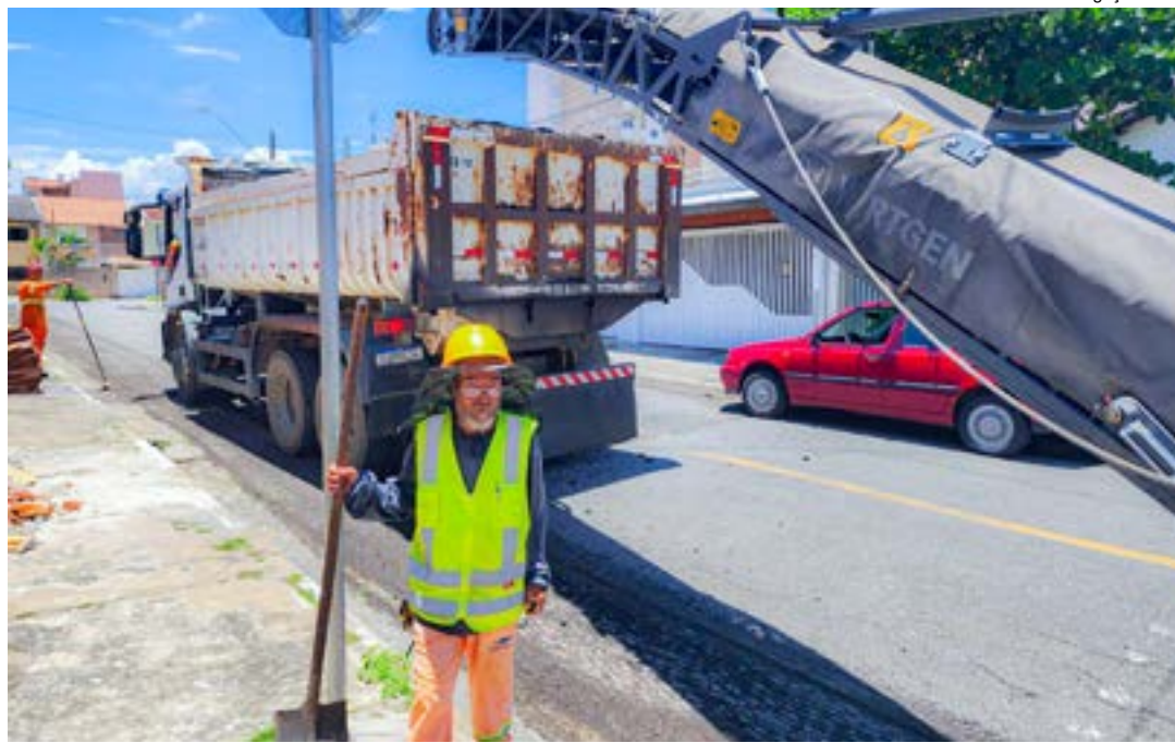
Funcionário da Prefeitura de Pindamonhangaba atua em obra de pavimentação no Parque São Domingos
