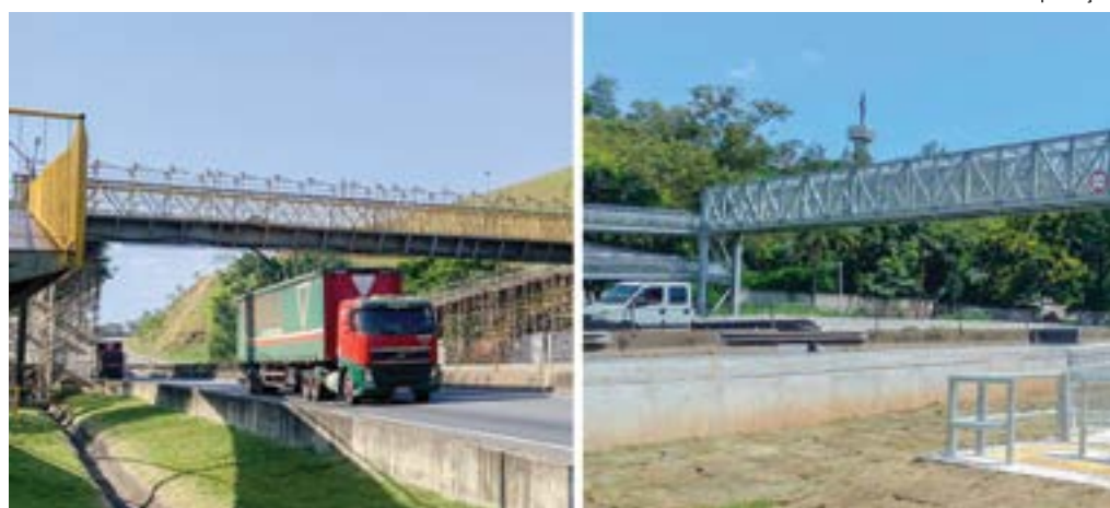
A antiga e a nova passarela, que liga o bairro Perpétuo Socorro à região central, sobre a Via Dutra
