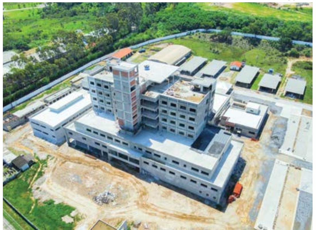
Vista aérea da obra do Hospital Regional; Estado investiu mais de R$ 130 milhões na construção, em Cruzeiro
