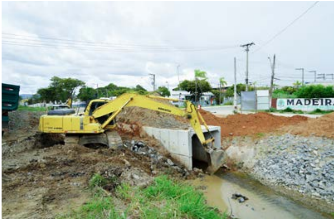
Trabalho de implantação de aduelas para drenagem; obra da Vila Nunes tem investimento de R$ 1,6 milhão
