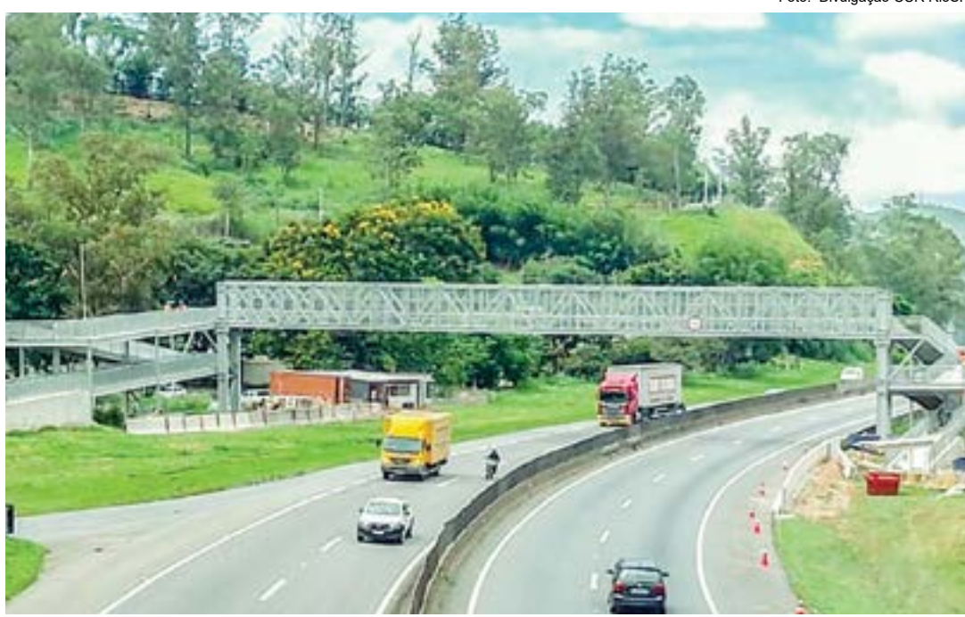
Passarela instalada no trecho de Aparecida da Via Dutra; obra de R$ 6 milhões deu fim à ação judicial
