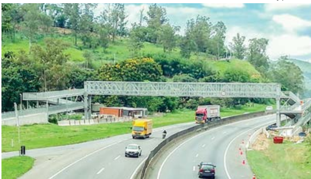
Passarela instalada no trecho de Aparecida da Via Dutra; obra de R$ 6 milhões deu fim à ação judicial
