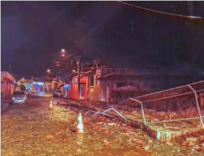
Destruição com a chuva em Piquete; áreas de risco são monitoradas
