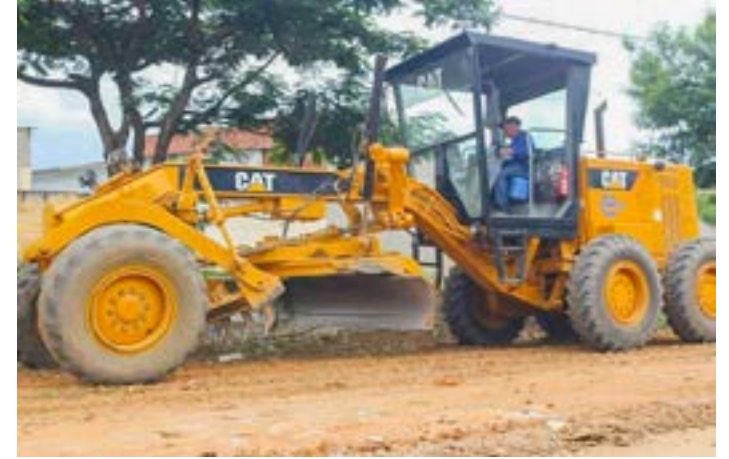
Maquinário já atua na pavimentação de 52 vias de Guaratinguetá
