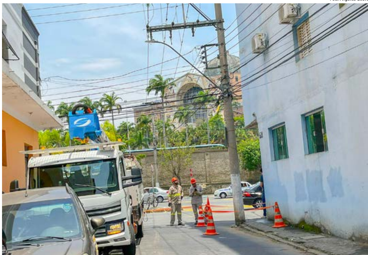
Trabalho da EDP em postes da região central de Aparecida; após hotéis ficarem sem energia no período de calor, setor cobra melhorias
