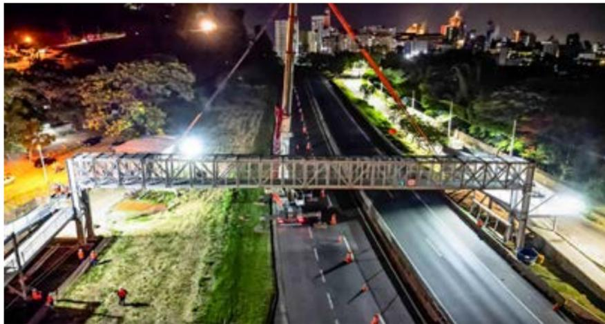
Trabalho para instalação de nova passarela no km 69,4 da Dutra; estrutura tem comprimento de 47 metros
