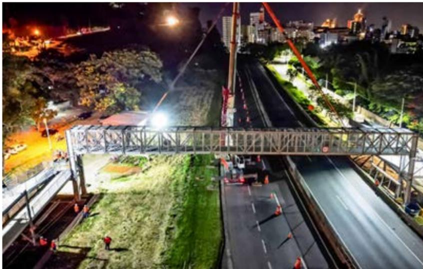
Trabalho para instalação de nova passarela no km 69,4 da Dutra; estrutura tem comprimento de 47 metros
