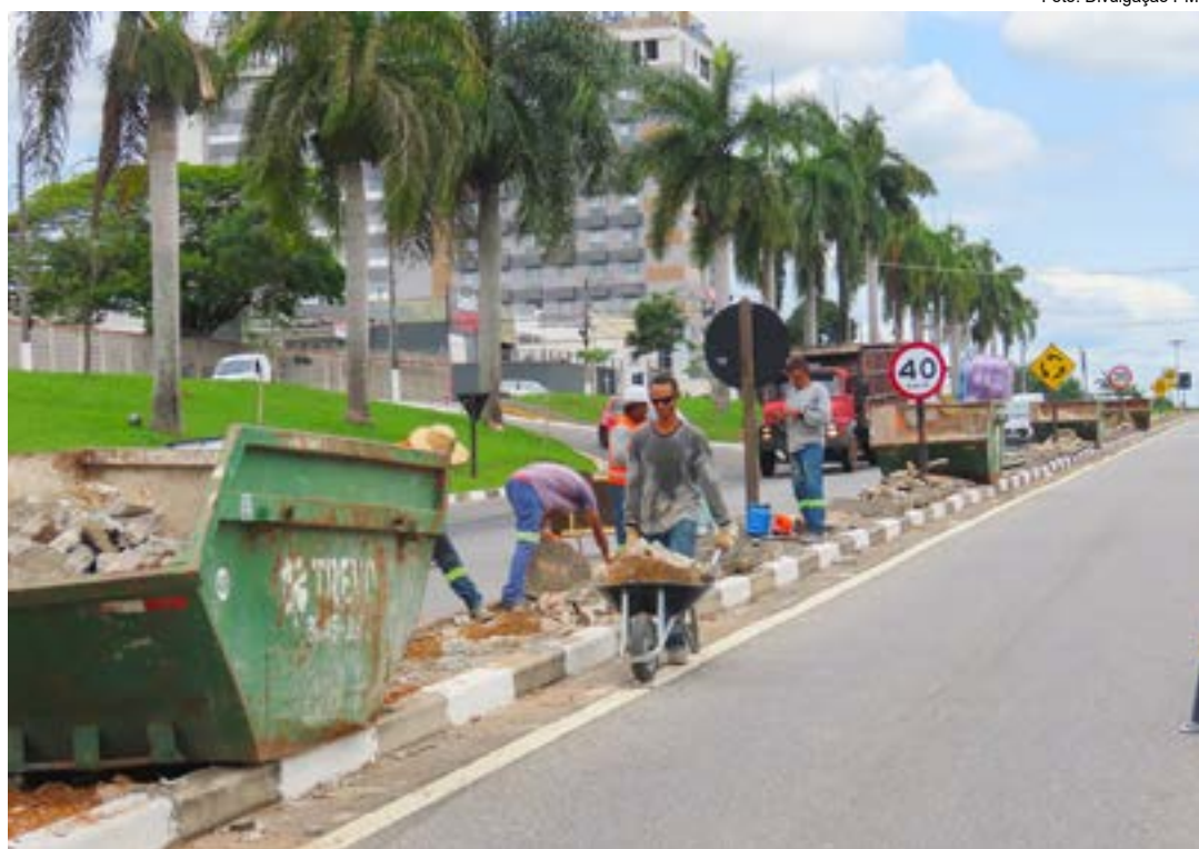
Trabalho de modernização da Nossa Senhora do Bom Sucesso; Multivale à frete de obra de R$ 5,8 milhões
