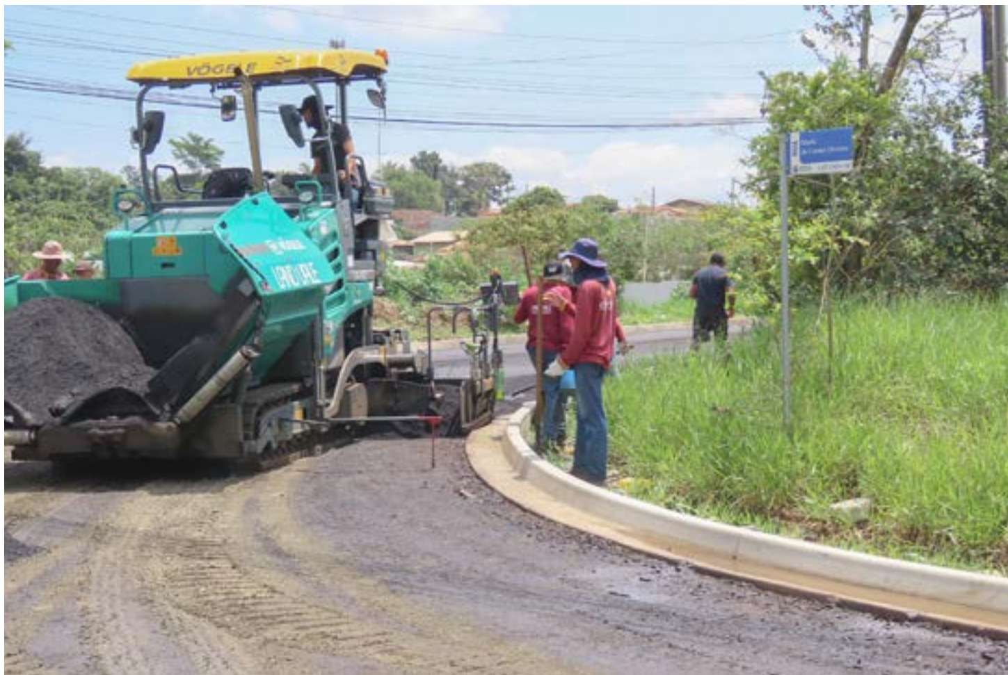
Trabalho de pavimentação que atendeu ruas e avenidas no bairro Shangri-lá; Pindamonhangaba anuncia investimento em mobilidade urbana
