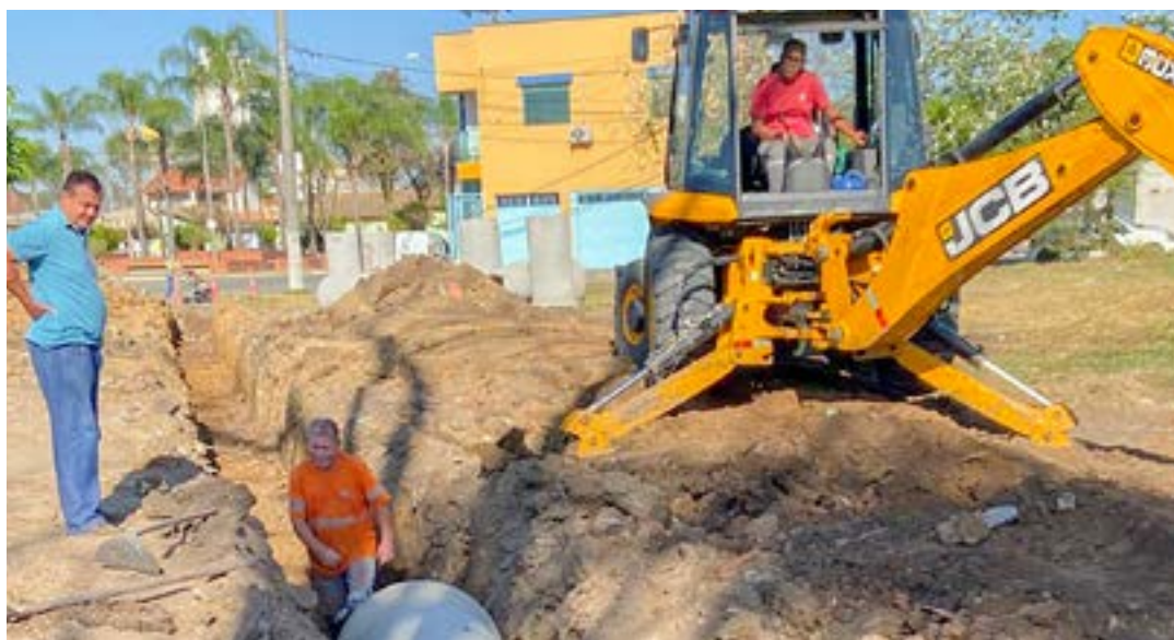
Trabalho para implantação de galerias pluviais para a Vila Geny; medidas procuram evitar alagamentos
