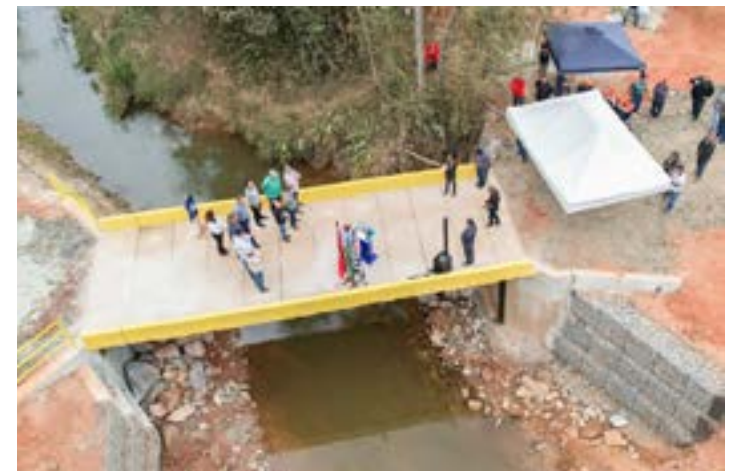
Reinauguração da ponte do Poço Fundo; obra contou com R$ 235 mil
