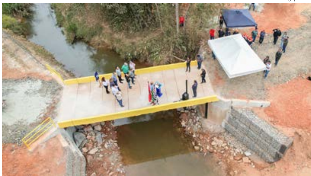
Reinauguração da ponte do Poço Fundo, em Lorena; obra contou com investimento de R$ 235 mil
