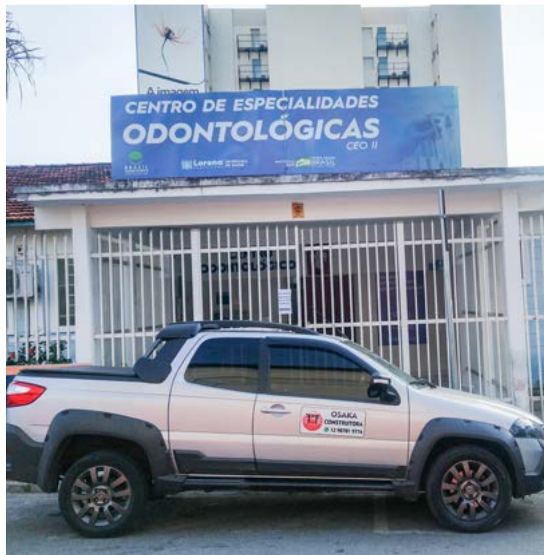
Centro de Especialidades Odontológicas, na região central de Lorena, que passa por adequação de espaço
