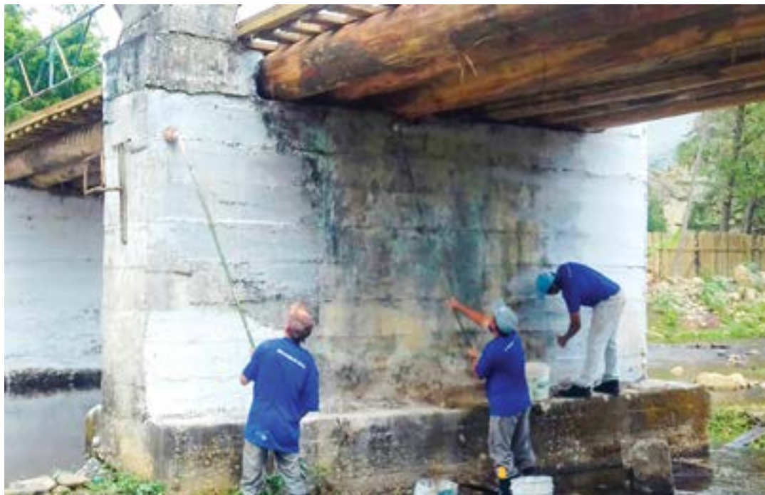
Obra de 2017, que focou estrutura da ponte do Taquaral, será repetida com verba de R$ 1 milhão neste ano
