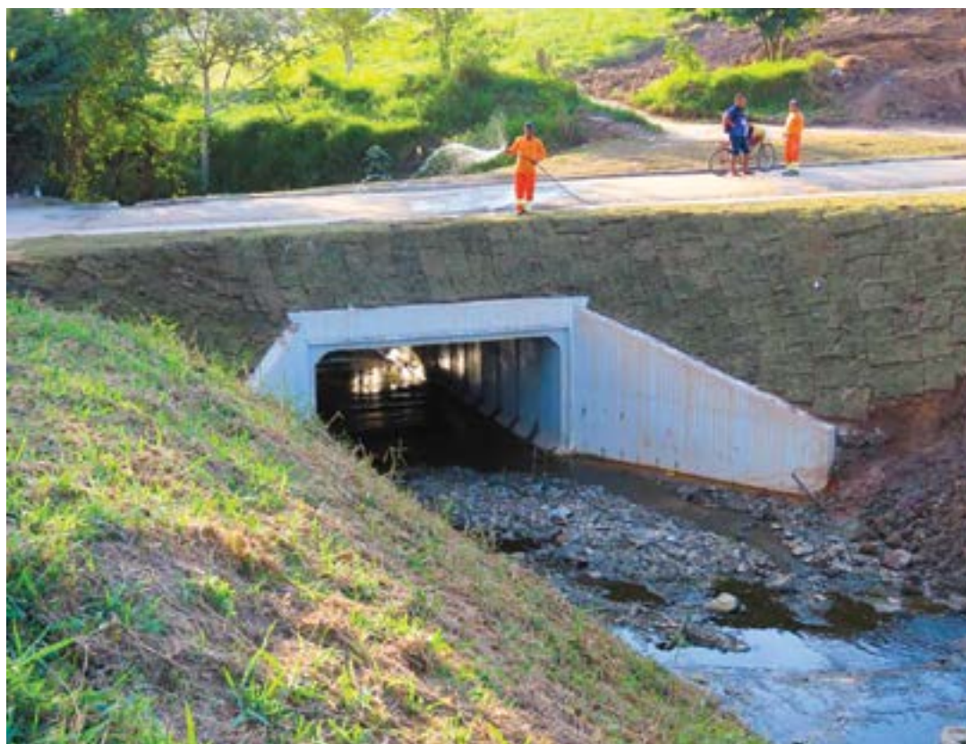
Obra no Araretama; com previsão de conclusão para setembro, estrutura beneficia quinhentas famílias
