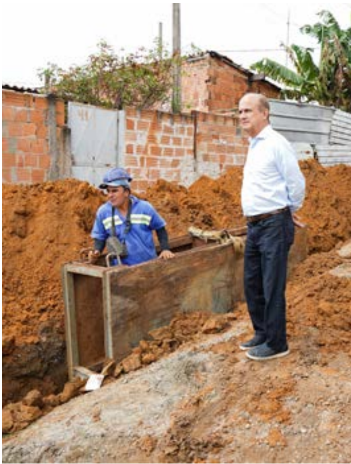
Ballerini vistoria obra em área regularizada do Parque das Rodovias
