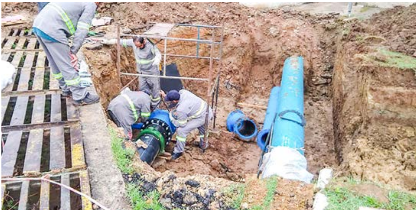
Trabalho realizado pela equipe do Saeg; autarquia amplia atendimento com água encanada para moradores do Vila Nova, próximo à Rocinha
