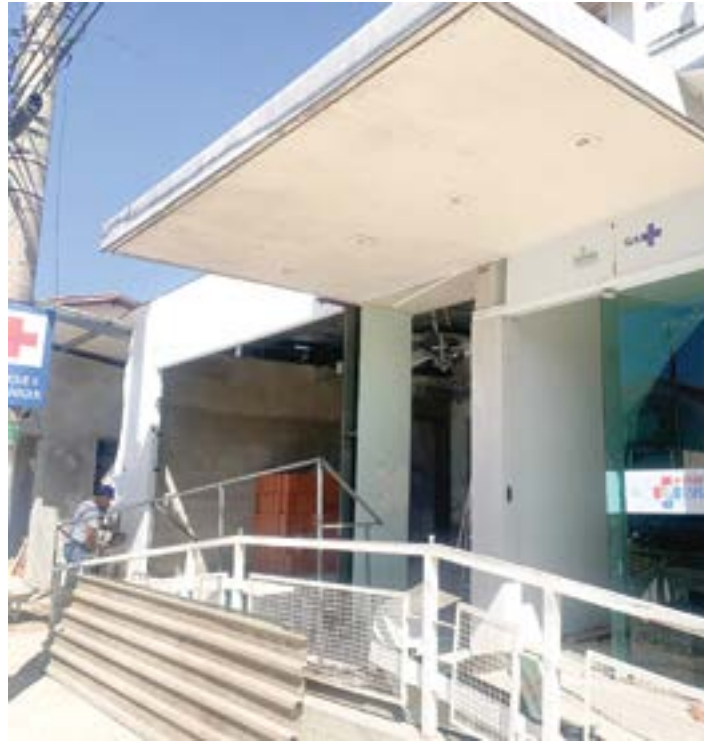
Obras no antigo PS; prédio será usado como setor oftalmológico
