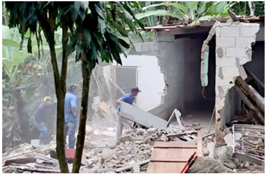
Trabalho de demolição de construção irregular em Caraguatatuba; cidade aumenta fiscalização sobre obras
