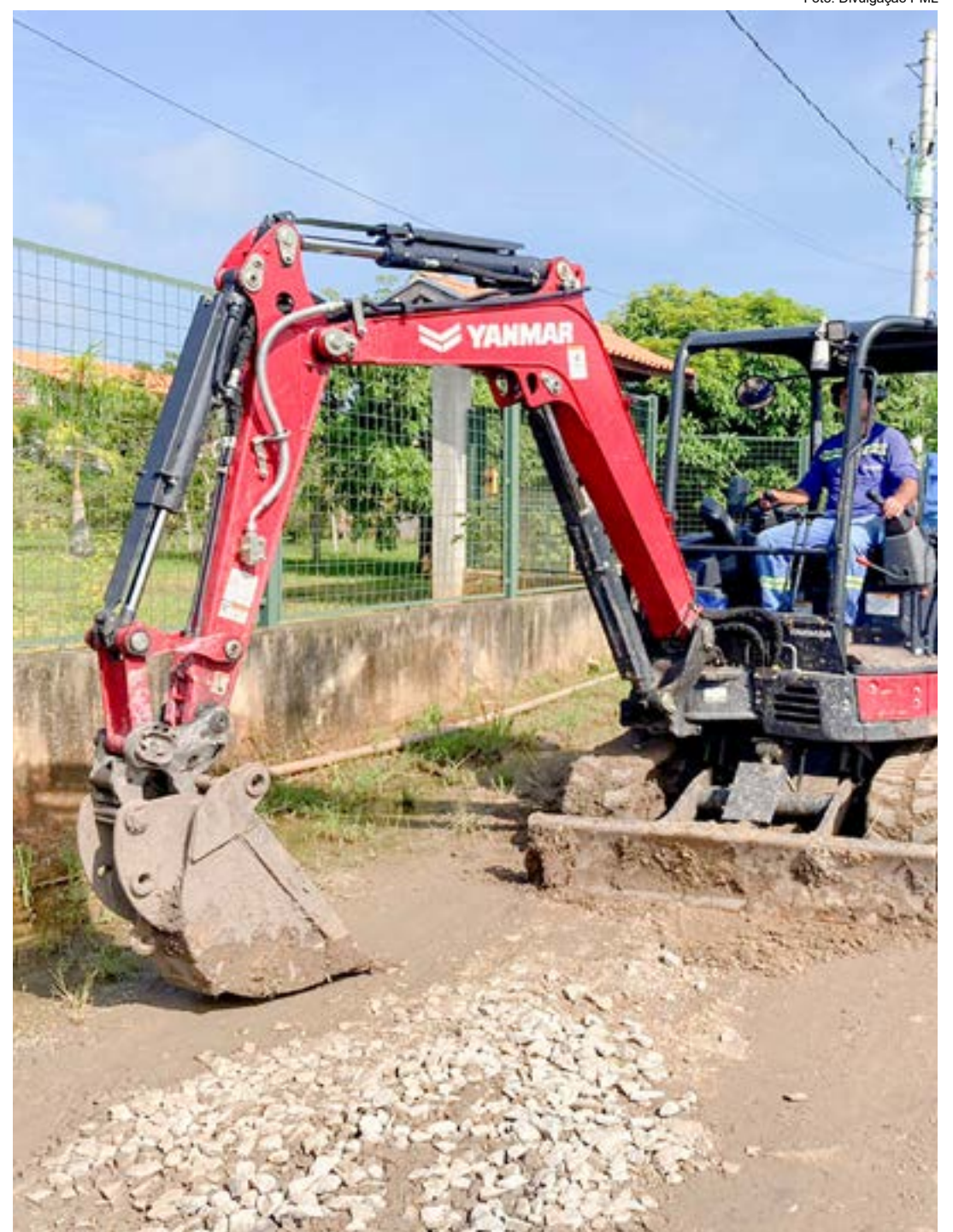
Trabalho de recuperação de rua em Pindamonhangaba; desatualização faz TCE apontar obras paralisadas
