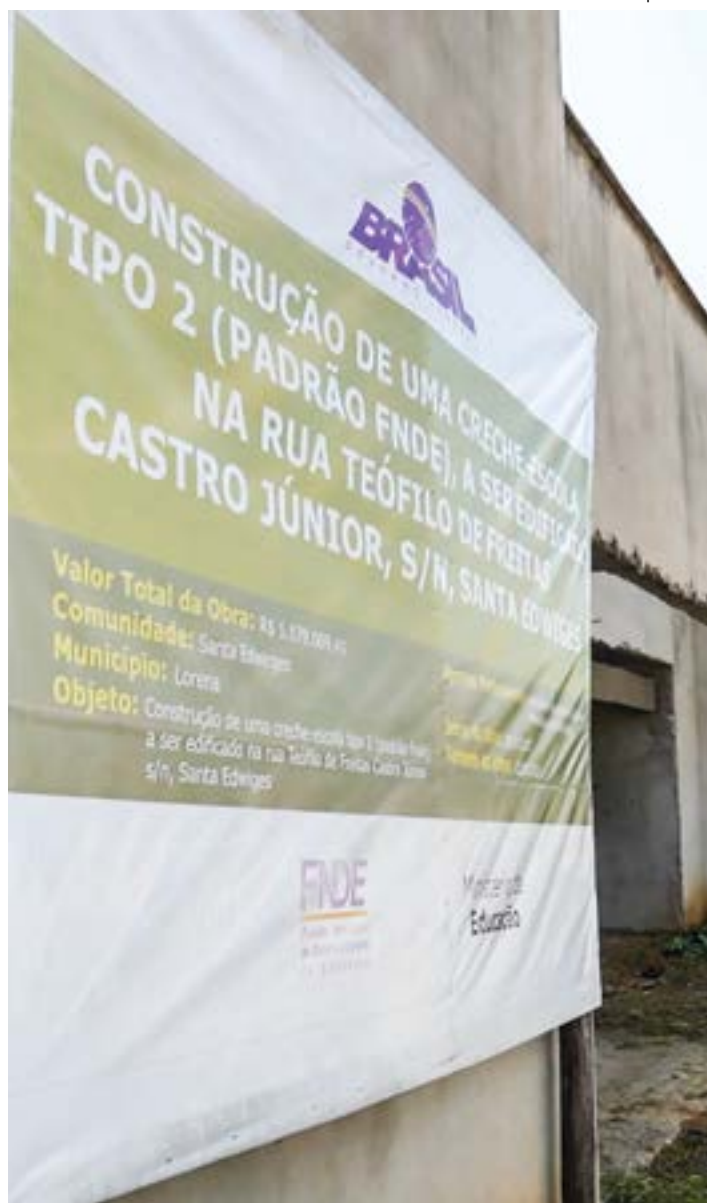
Placa de obra em Lorena que segue em finalização, contrariando TCE
