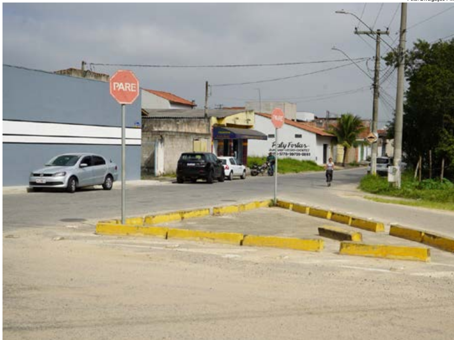
Rotatória no bairro Vila Comerciários 2, que faz parte de novas ações em Lorena; Prefeitura anuncia outras obras no bairro, nesta semana
