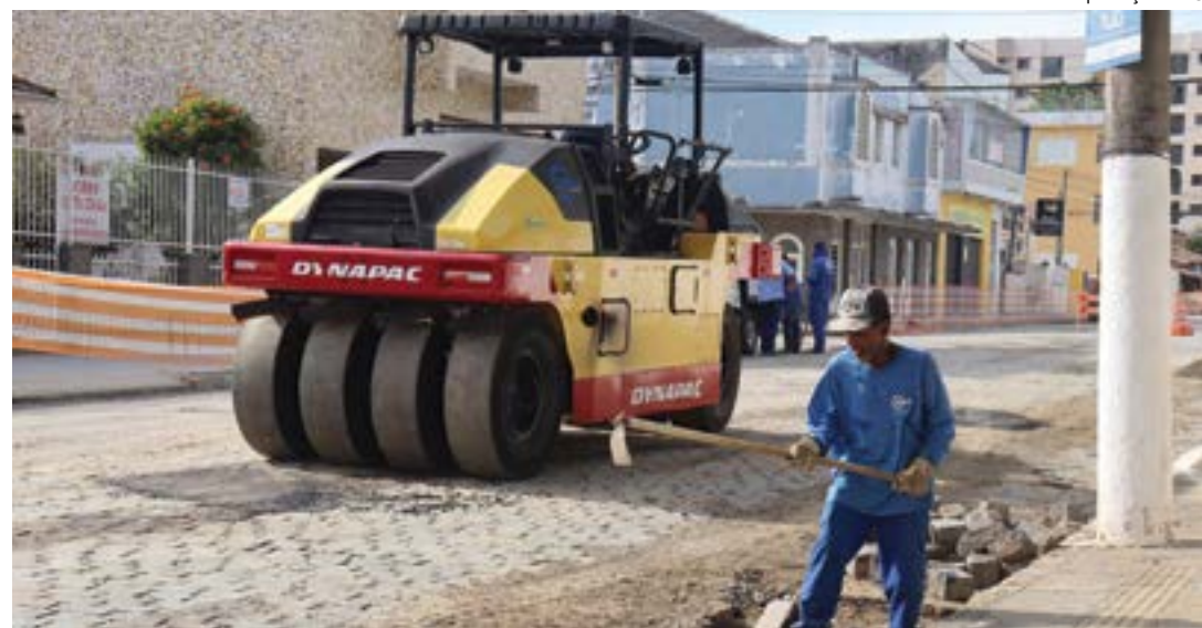
Obras no bairro do Pedregulho, nesta semana em Guará; Prefeitura avança com obras de infraestrutura
