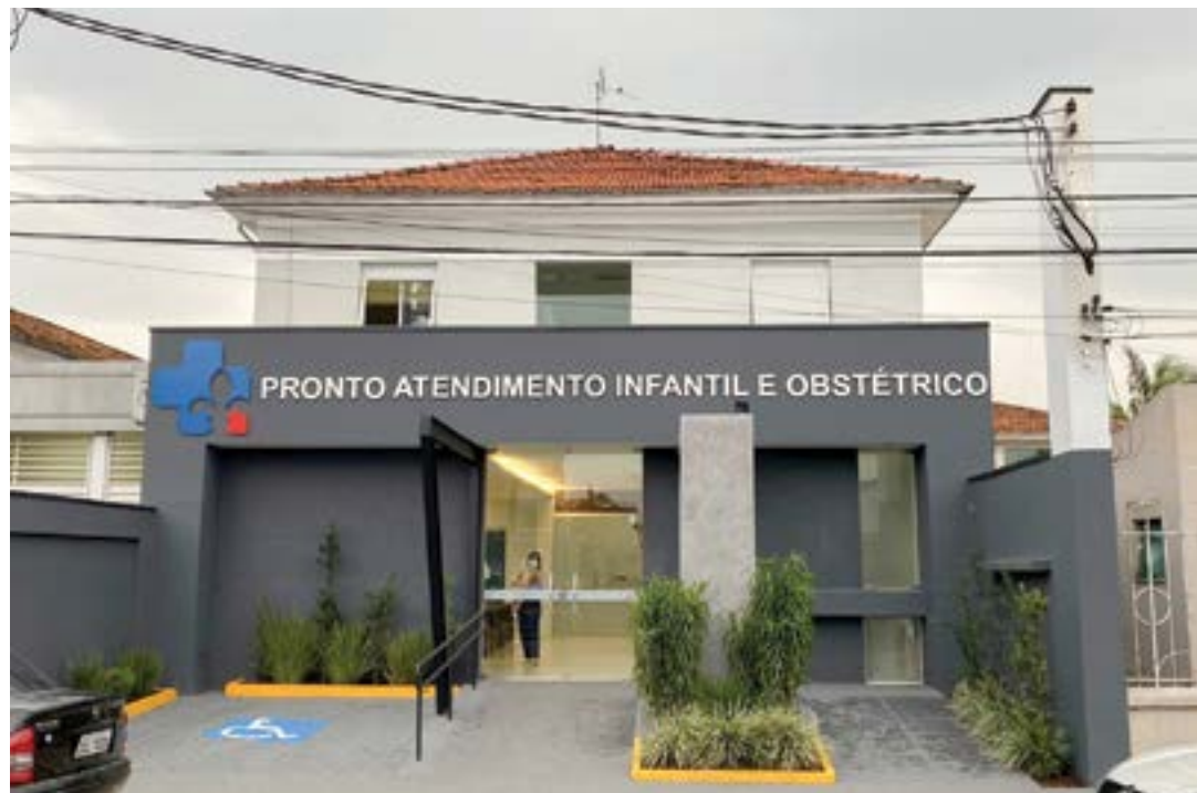
Fachada do Pronto Atendimento Pediátrico de Lorena; espaço funciona com testes para protocolos
