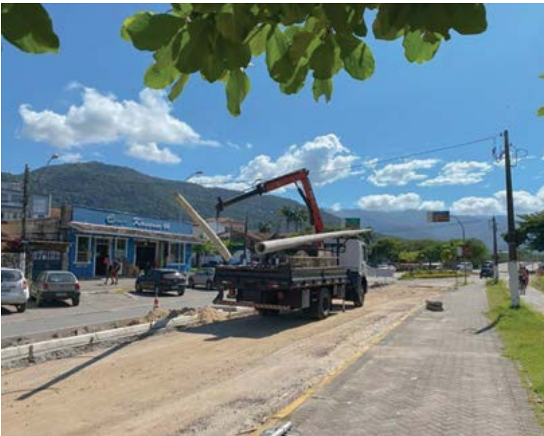
Avenida Iperoig, em Ubatuba, que recebe obra com investimento de R$ 4,704 milhões; trabalho é retomado
