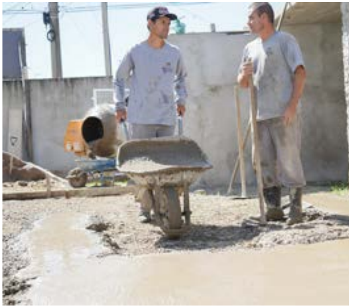
Construção de creche em Lorena; unidades devem gerar 240 vagas
