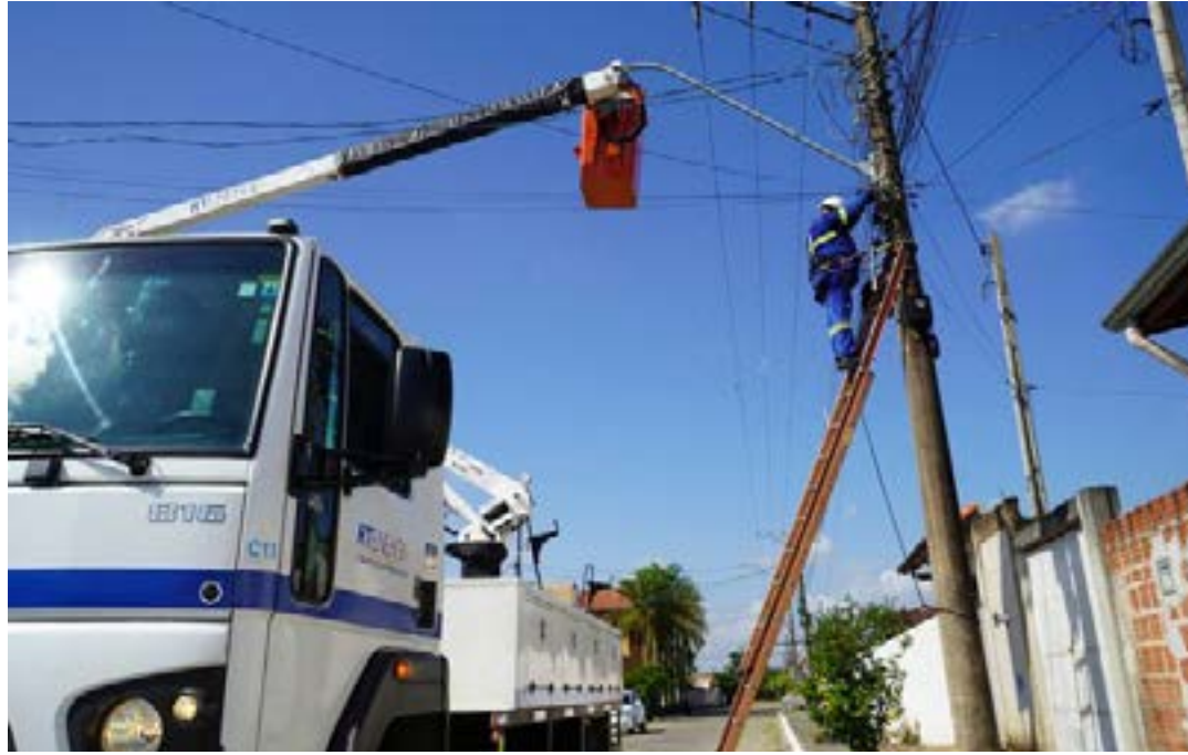
Trabalho de troca do sistema de iluminação em Lorena por LED; planejamento continua pelos bairros
