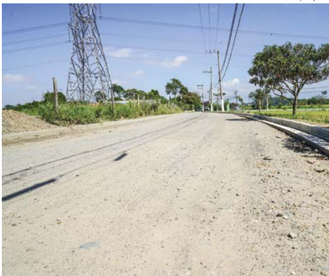
Estrada dos Marques, em Lorena, um dos pontos que serão pavimentados com investimento municipal
