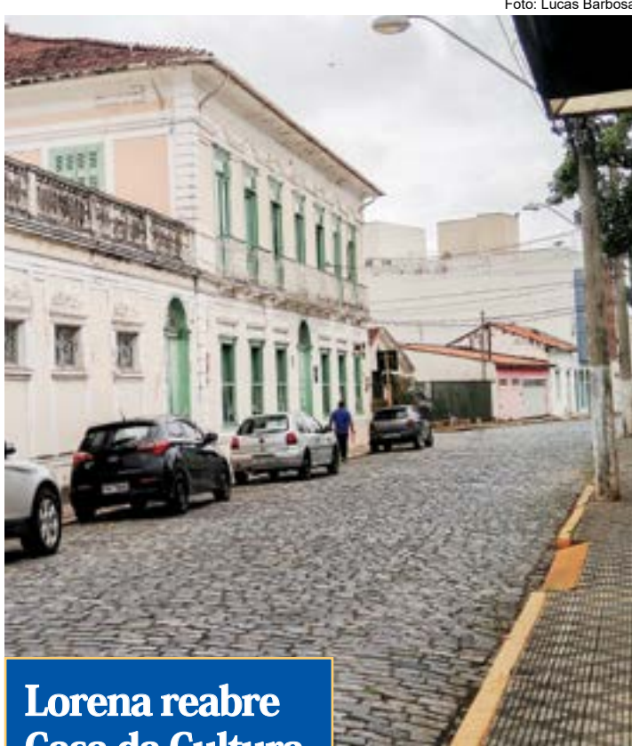
Casa da Cultura; aberta em obras
