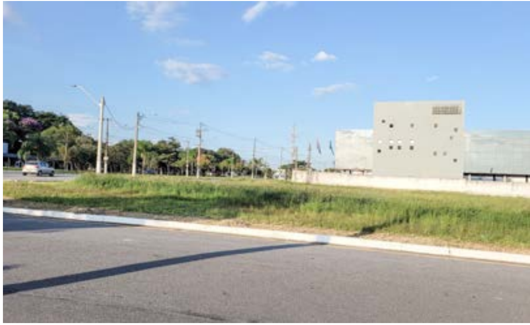
Área próxima à Unesp e Fórum, onde será construída nova sede do Legislativo em Guará; terreno aprovado
