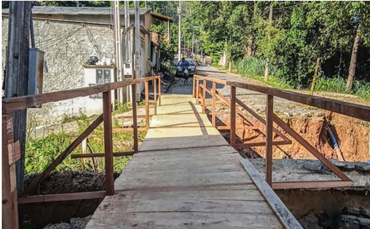
Ponto provisório de passagem implantado no acesso ao Turma 26, após queda da ponte, em Cachoeira
