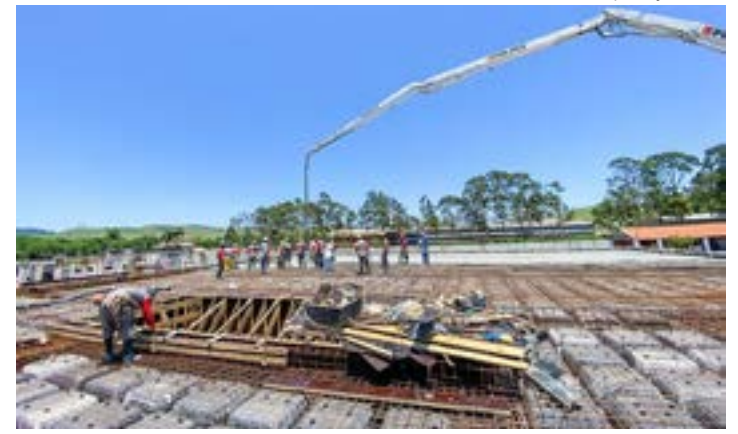
Trabalho na construção do Hospital Regional; anúncio de ampliação
